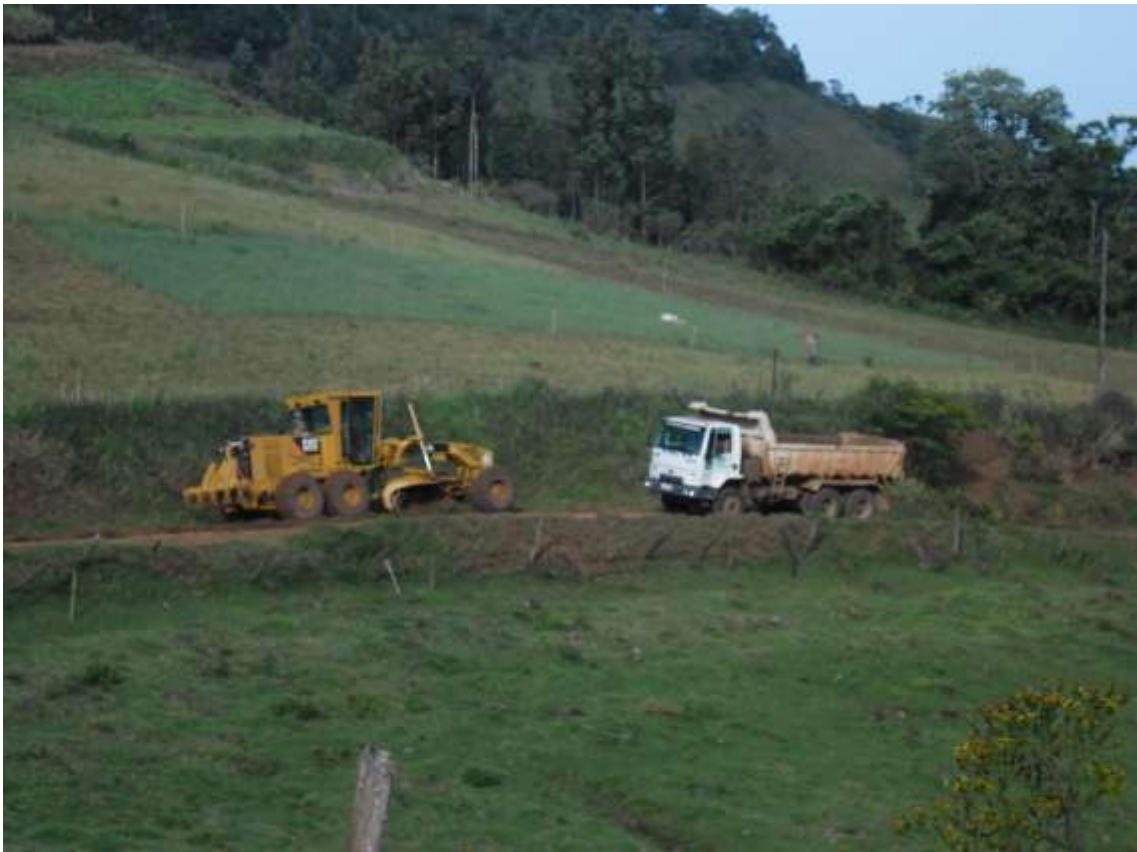
Manutenção de estradas
