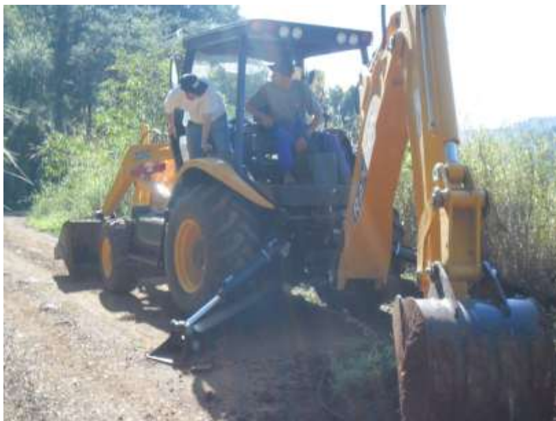
Manutenção de bueiros
